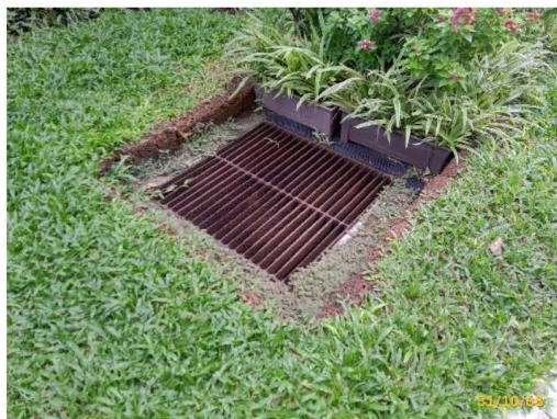
บ่อพักน้ำก่อนระบายออกสู่ท่อระบายน้ำสาธารณะ
